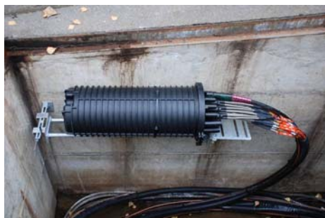
Abbildung 18 Verlegung Spleissmuffe
